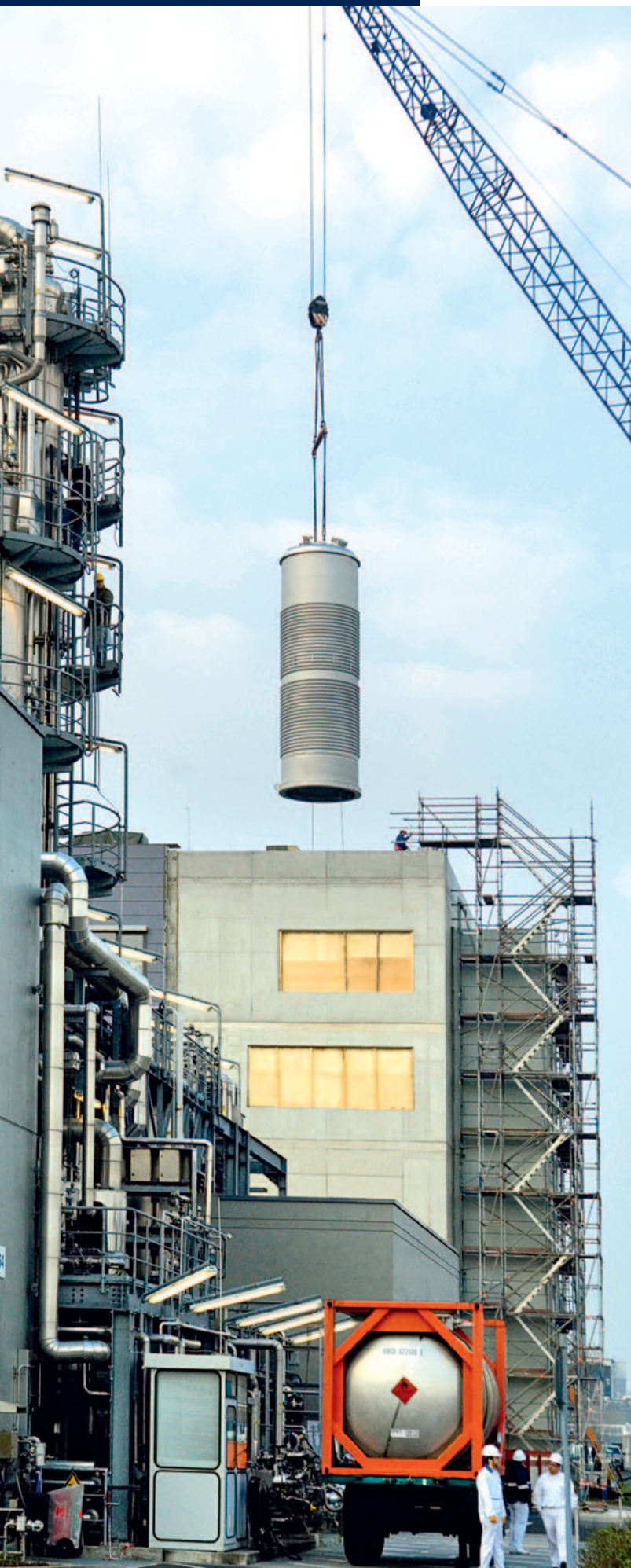
Einbau eines neuen Fermenters zur Insulinproduktion in Frankfurt a.M.
